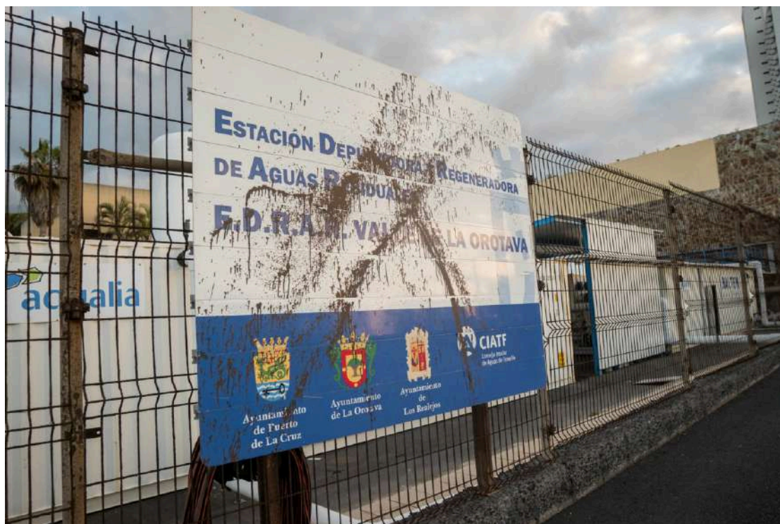
El incidente tuvo lugar el sábado en las instalaciones de la depuradora comarcal y sus causas y posibles consecuencias se siguen investigando. Fran Pallero
